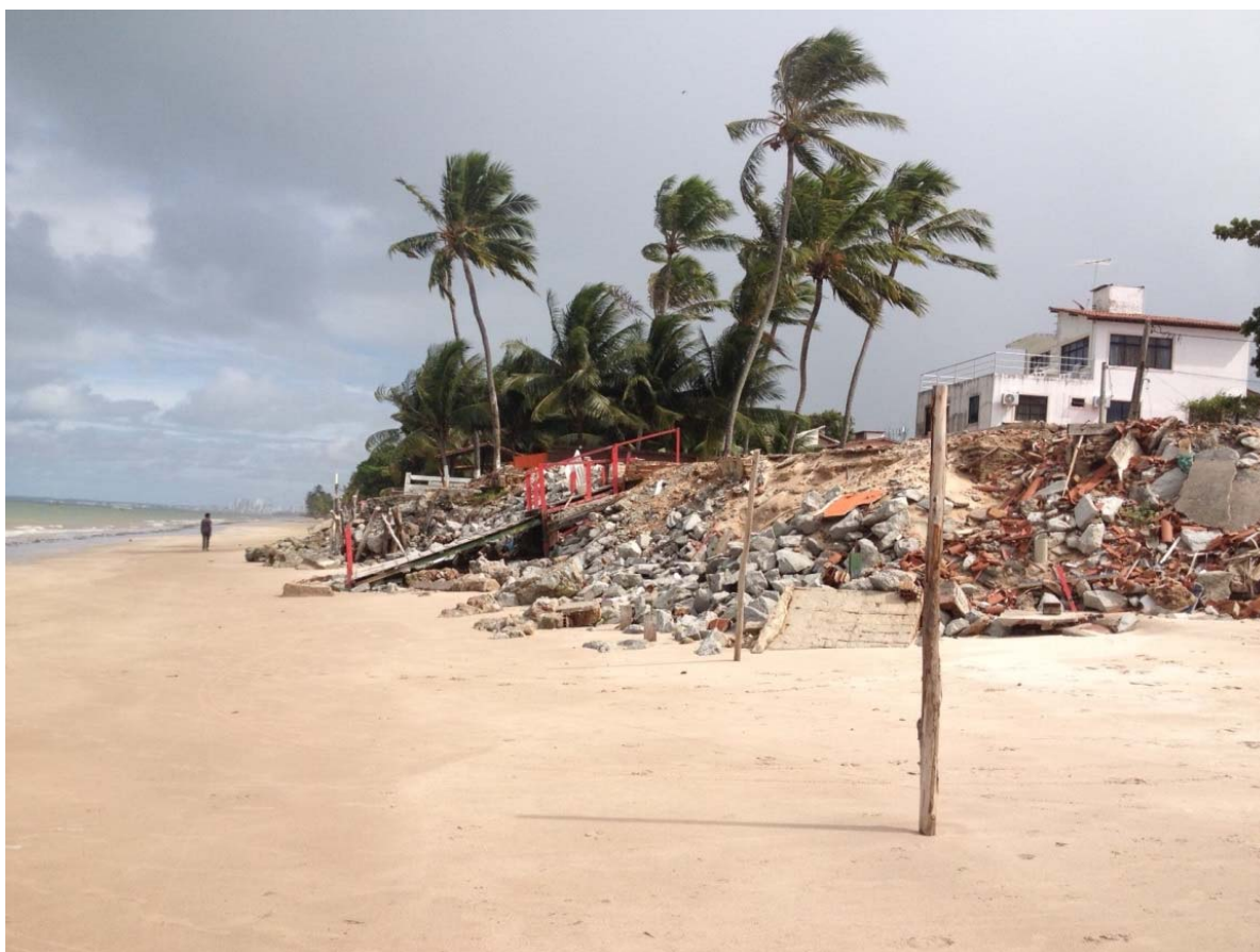
Figura A – Evidências erosivas. Estruturas fixas destruídas e ameaça a residências. Foto: Francisco Rafael Melo Patrício
